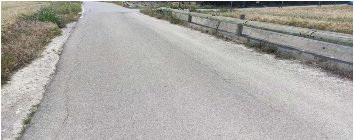
VIAL MUNICIPAL, a la derecha de la foto se observa la barrera de seguridad sobre el muro del torrente.
